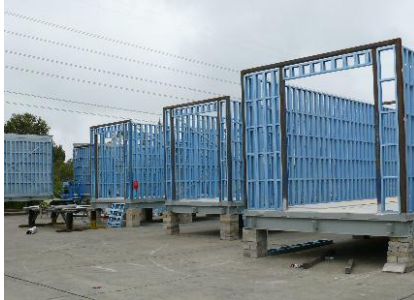
APLNG Switchroom Frames
