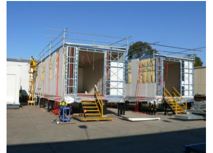
ABB Train 1 HV VSD 1505 & 1506
